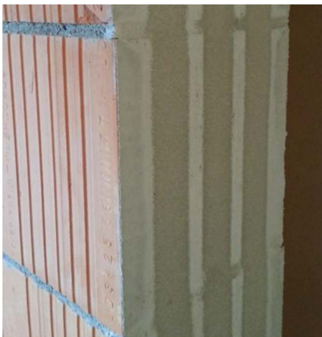
Fot.2 Wyrównanie gładzi zaprawą termoizolacyjną illbruck PR005 - pierwszy etap do uzyskania szczelności połączenia okna z bryłą budynku
